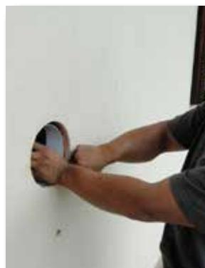
4. inserimento scambiatore calore
